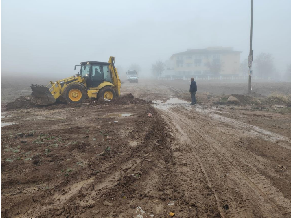
Safirkent İle Okullar Bölgesi Yeni Açılan Yola Dağ Malzemesi Serpme Çalışması
