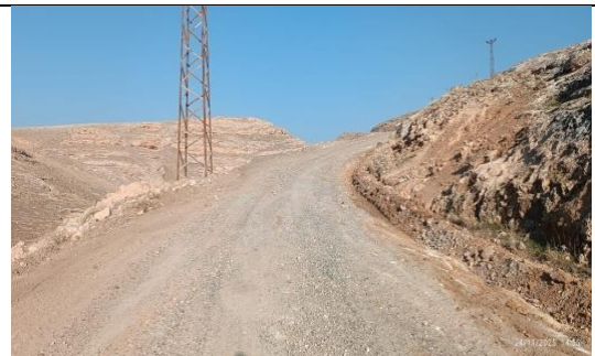
Aşağı Çayırılı –Yukarı Çayırılı Mahalle Yolu Reglaj Çalışması
