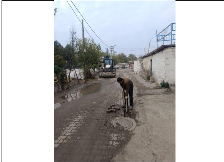
Dicle Mahallesi Su Tahliyesi Onarım Çalışması
