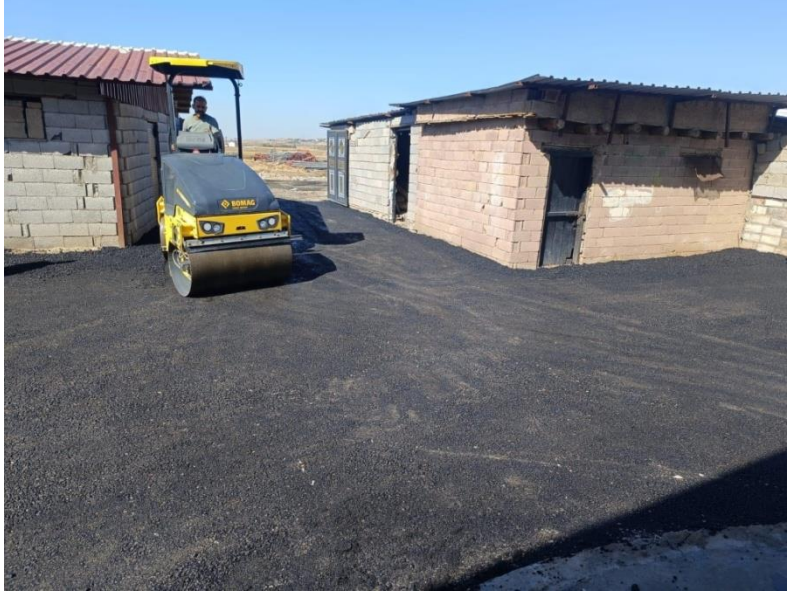
Alibey İlkokulu zemin düzensizlik ve asfalt çalışması
