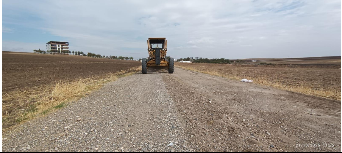
Akköy Mahallesi İle Kopmaz Mahallesi Arasındaki Yol Çalışması
