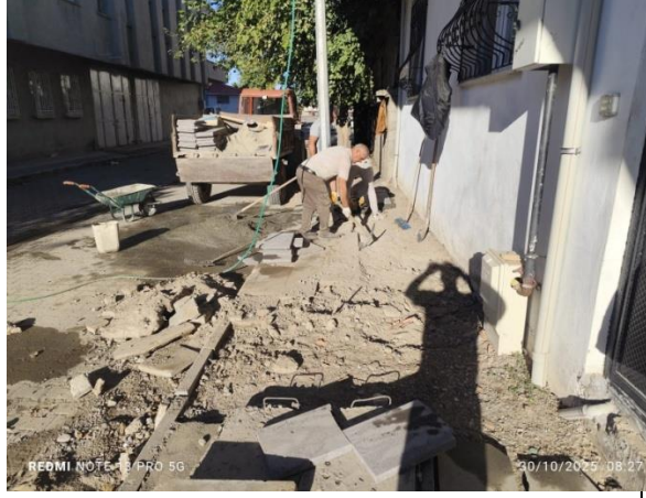
Fırat Mahallesi Kaldırım Onarımı Çalışması
