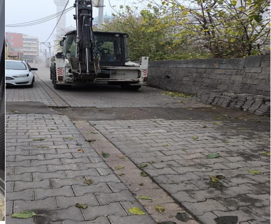
Fırat Mahallesi Kilitli Taş Onarımı Çalışması
