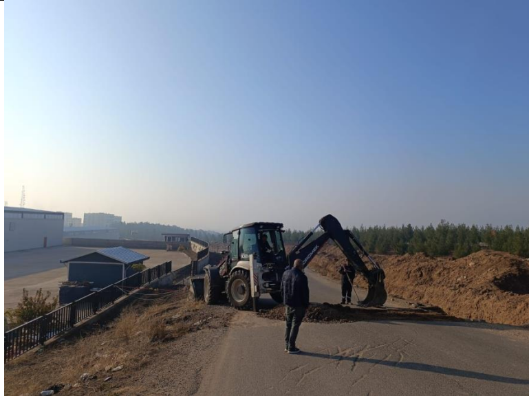
Tekstil Kent Asfalt Öncesi Zemin Hazırlama Çalışması
