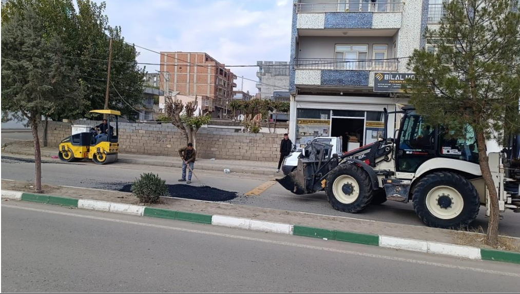
Nato Caddesi Asfalt Çalışması
